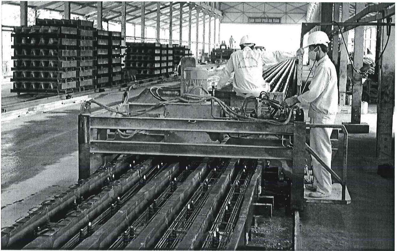
CĂNG KÉO CÁP SẢN XUẤT TÀ VỆT BÊ TÔNG DỰ ỨNG LỰC
